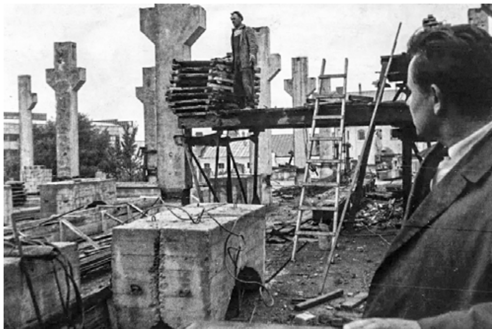
На старте строительства тарно-посудного цеха винно-водочного завода «Кристалл». На переднем плане — главный инженер завода Н.Т. Белко. Конец 60-х годов XX века
